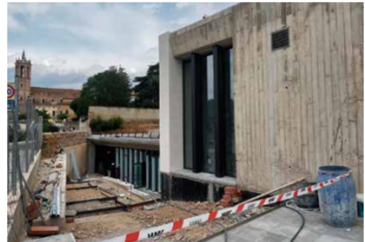
Imatge del procés de construcció del nou tanatori, el juliol de 2025. > CEDIDA
