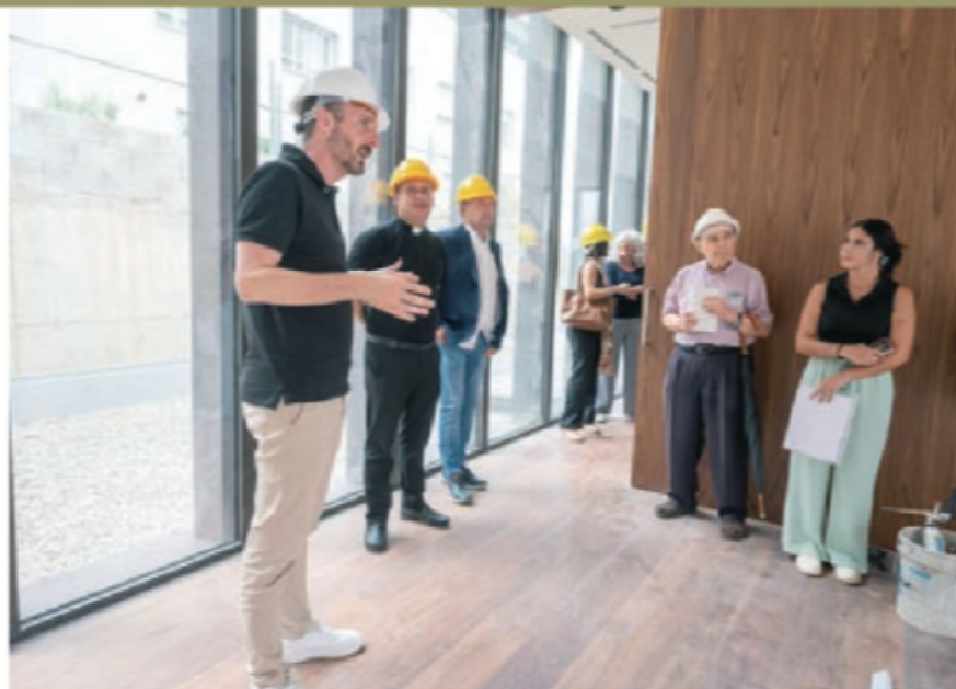
Una visita d'obres al nou tanatori, que ha endarrerit l'obertura per problemes amb la instal·lació dels ascensors
